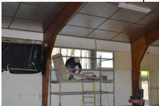
Vues intérieures et extérieures de la dépose des fenêtres arrières
